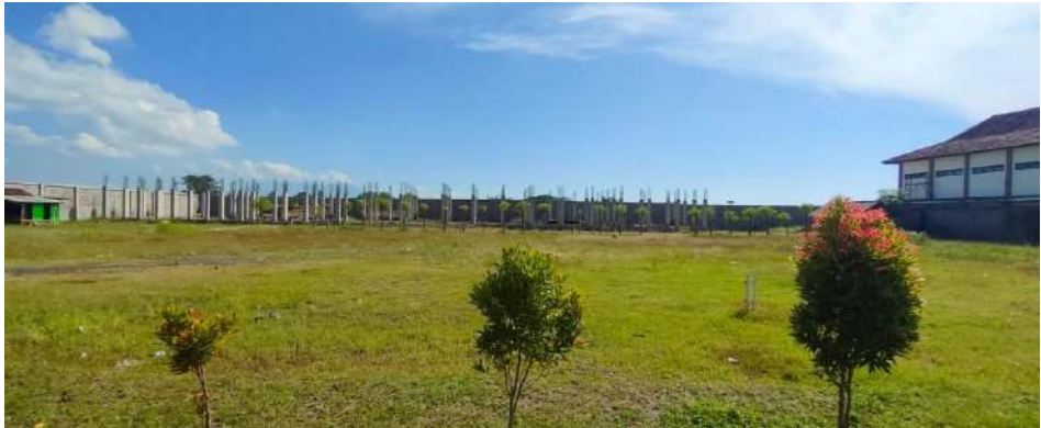
Proses Pembangunan Gedung Pendidikan, (Sumber: observasi 2025)
