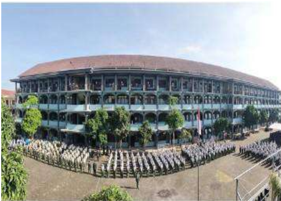
Gedung SMA Darussalam
